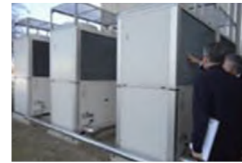
現場調査の様子
