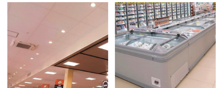
天井照明の LED 化や自然冷媒を使用したショーケース導入を進めている。
