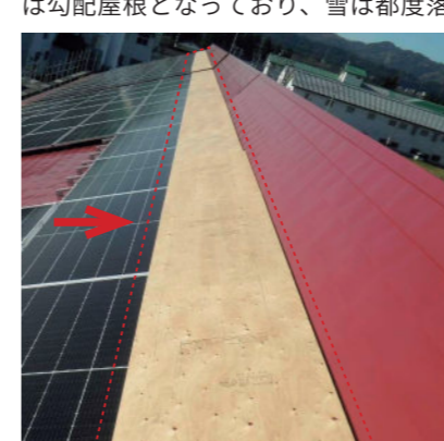
パネルと屋根の段差を木工工事で埋めている。
